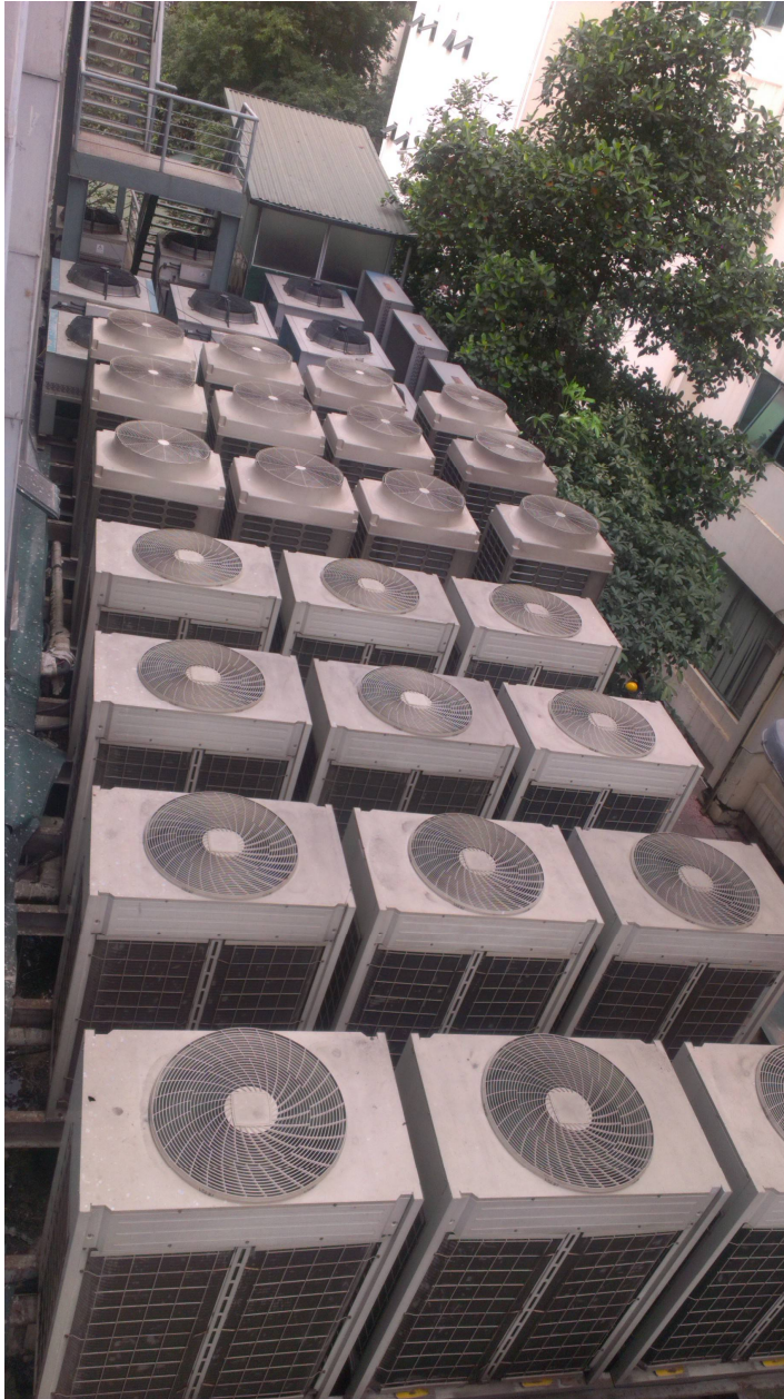
Công trình: Lắp đặt, bảo trì, sửa chữa hệ thống điều hòa trung tâm VRF -Toshiba và Daikin VRV – II và VRV- III tại Trung tâm Quản lý điều hành mạng ( NOC) – Tổng công ty viễn thông Mobifone số 811 – Giải Phóng – Hà Nội
