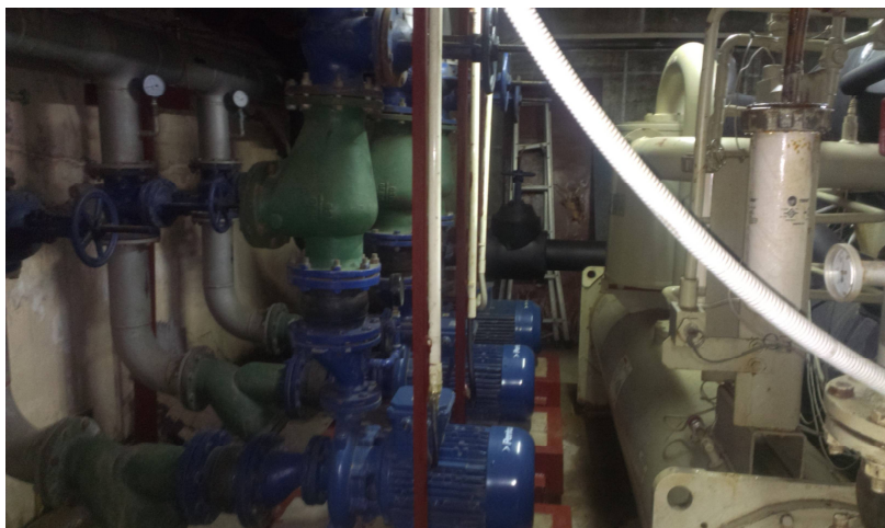
Công trình: Bảo trì, sửa chữa hệ thống điều hòa trung Trane giải nhiệt nước tại VNPT Hà Nội số 811 – Giải Phóng – Hà Nội
