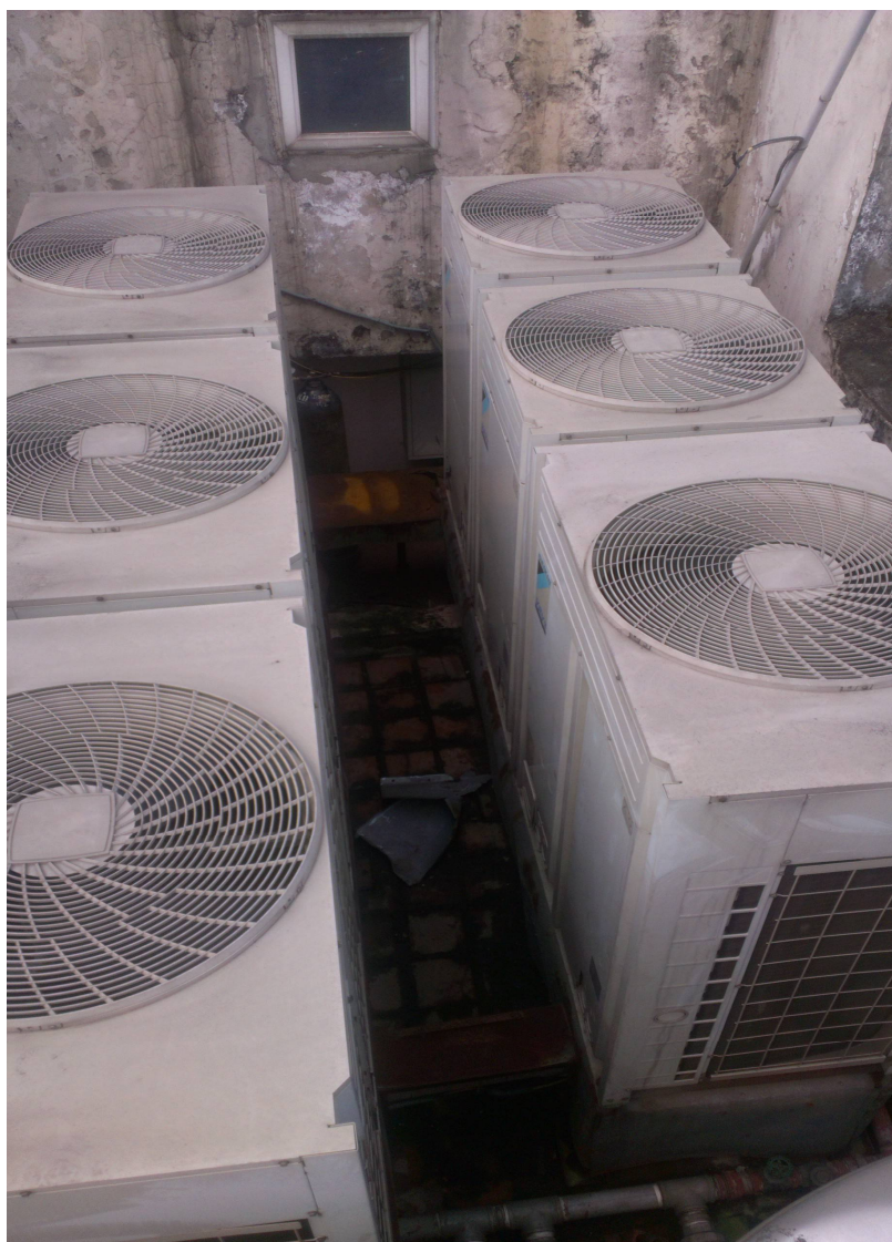
Công trình: Bảo trì, sửa chữa hệ thống điều hòa trung Daikin – VRV – II tại Cục quản lý lao động ngoài nước số 41B – Lý Thái Tổ - Hà Nội
