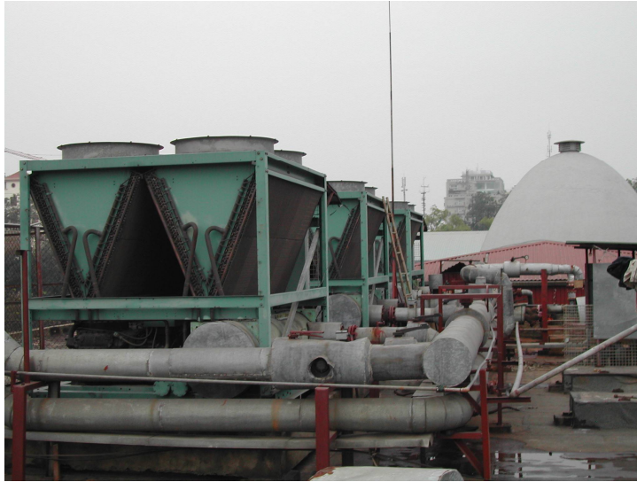
Công trình: Cung cấp lắp đặt hệ thống chiller – Cung văn hóa hữu nghị
