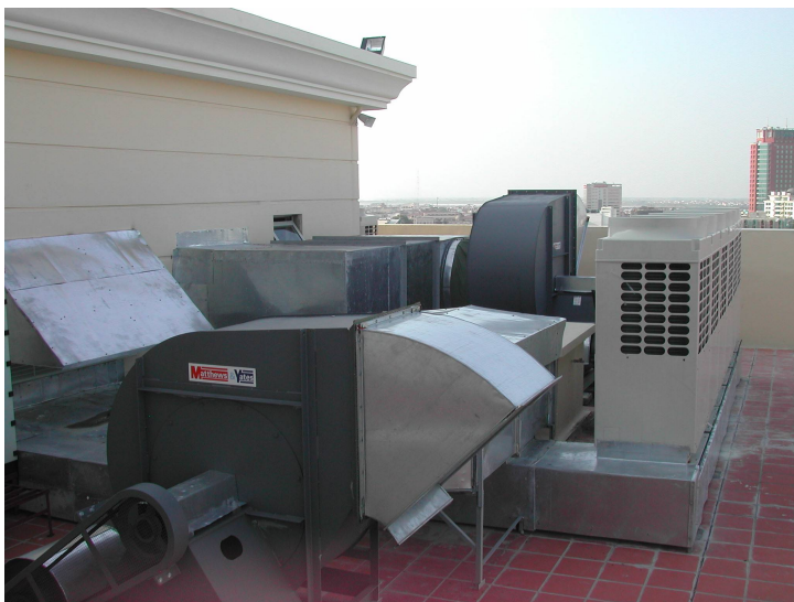
Công trình: Thi công và lắp đặt hệ thống điều hòa kiểu VRF- Toshiba - Trụ sở Bộ Tài Chính
